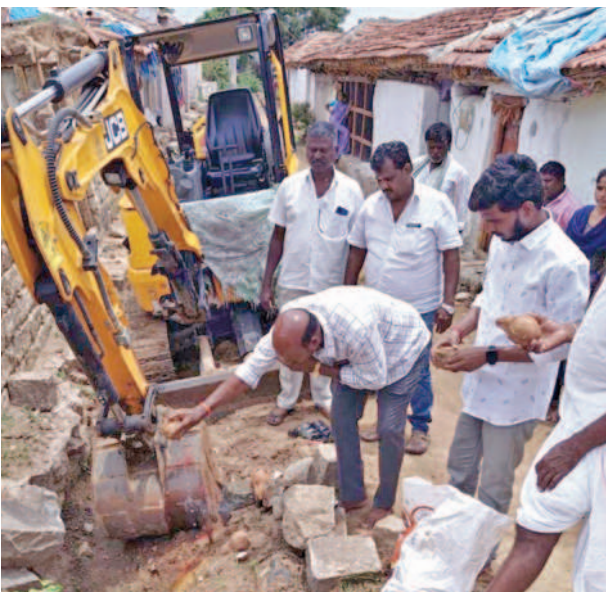
డ్రైనేజి పనులకు శంకుస్థాపన చేస్తున్న కాంగ్రెస్ పార్టీ నాయకుడు వెంకూరి శ్రీధరెడ్డి
